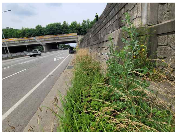
기초, 지반부 전경
