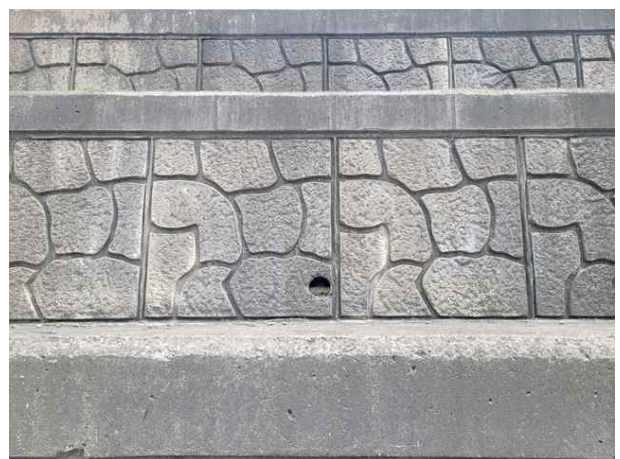
옹벽 배수시설 배수공 전경
