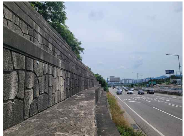
옹벽 1단 상부 전경
